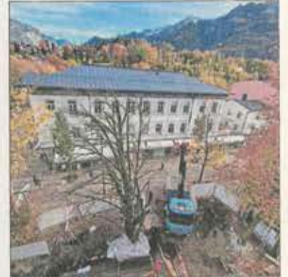
Der Gastgarten ist noch Baustelle.
