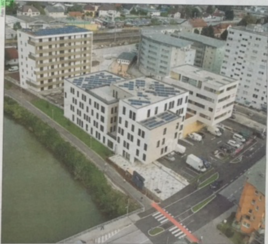
Das nagelneue BH-Gebäude an der neuen Adresse Schwarzstraße 14 mitten in der Salinenstadt
