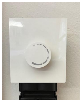
Flächenheizung TECE Einzelraum- Temperaturregelung mit Thermostatventil
