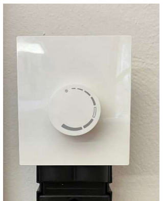
Flächenheizung TECE Einzelraum- Temperaturregelung mit Thermostatventil
